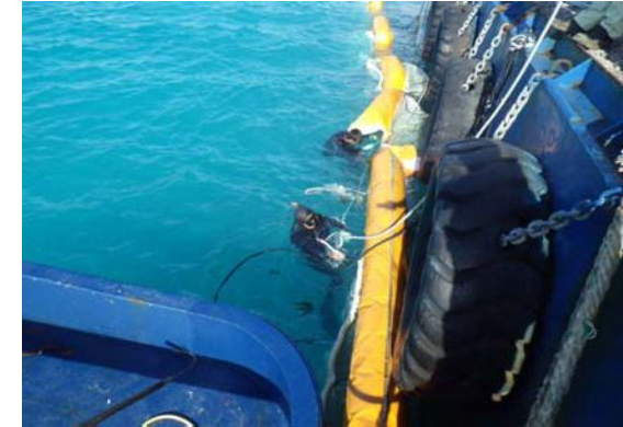
汚濁防止膜取替え状況②
