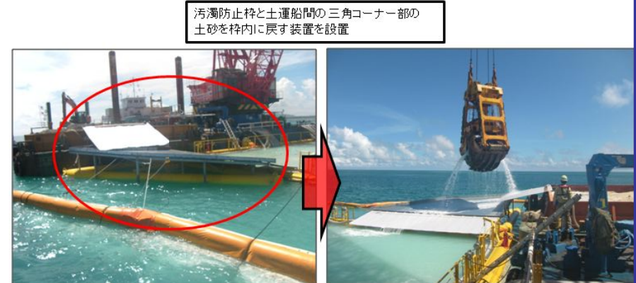
写真2.2 作業時の汚濁防止の工夫
