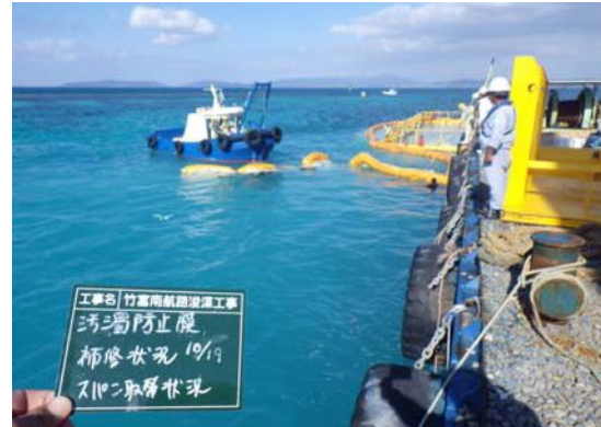
汚濁防止膜取替え状況①
