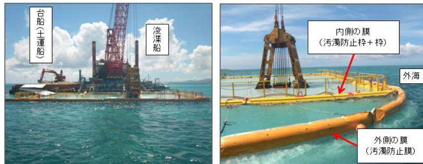
写真2.1 グラブ浚渫船の作業状況
