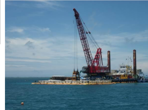
グラブ浚渫による施工
