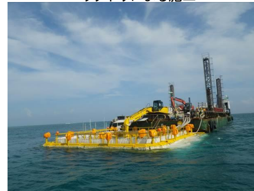
バックホウによる施工
