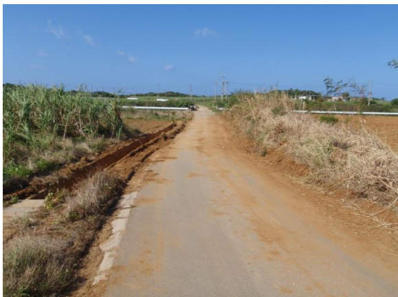
写真 赤土等の流出痕が残る農道
