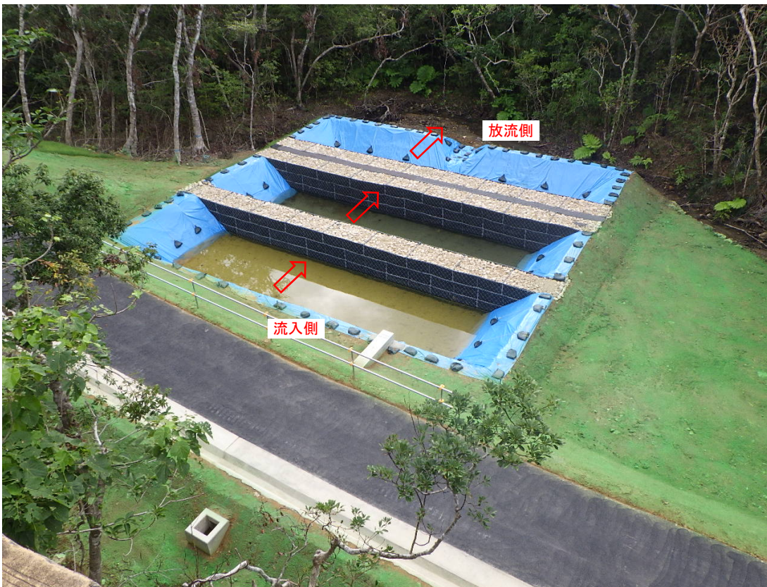
【公園工事における濁水流出防止対策】 事業現場から発生する濁水を導くことのできる沈砂池を設置し、工事を行った。
