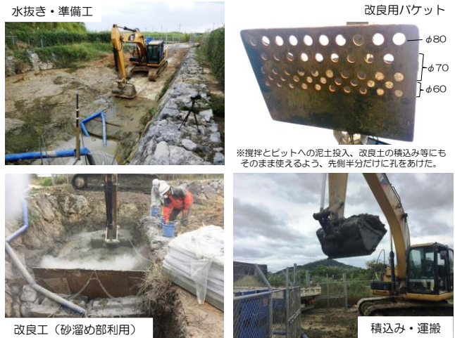
※沈砂池の堆砂容量 528m 3 、対象流域約 7.5ha。
