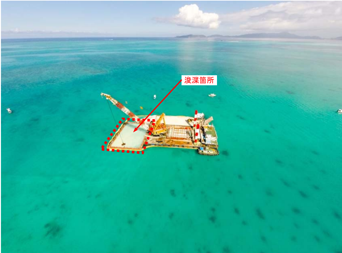
【航路浚渫工事における濁水流出防止対策】 濁水の流出を防止する汚濁防止膜を作業箇所の周囲に二重に設置し、浚渫工事を行った。
