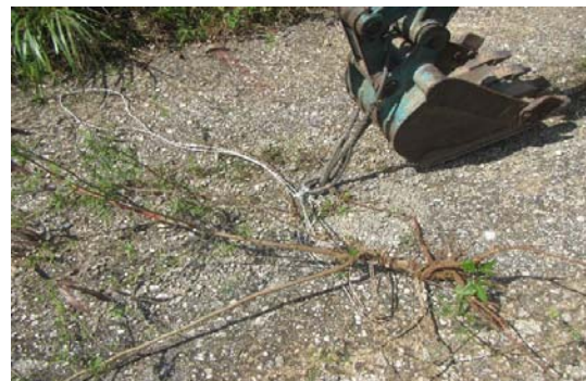
重機を使用したギンネムの抜き取り
