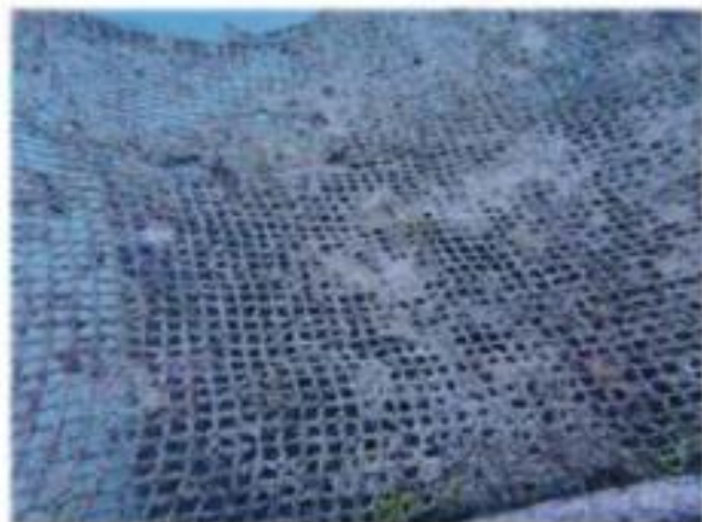
【C-5】ラン藻類の付着、浮泥堆積が多い
