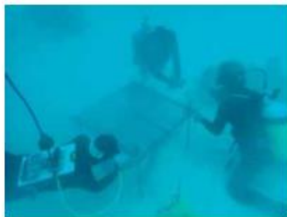
架台の設置状況
