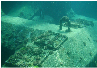
図 4-13 那覇港のエコブロックと 着生状況
