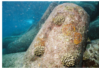
図 4-14 平良港のエコブロックと 着生状況
