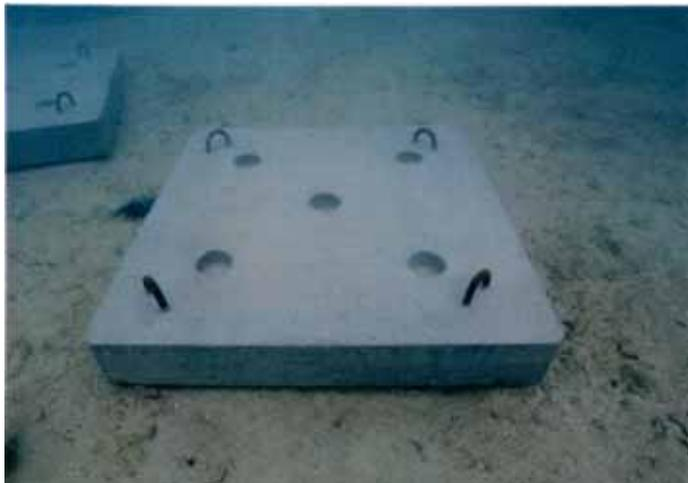
図 6-17 . 海底に設置された人工基盤
