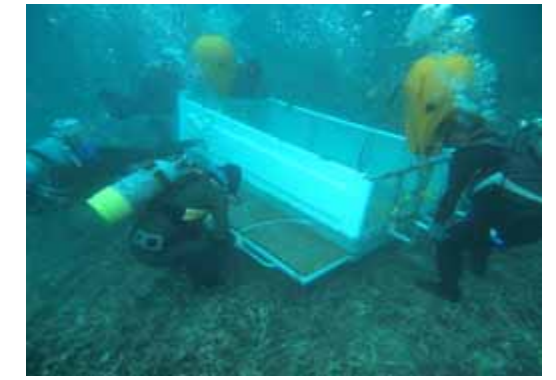
写真 2.11 移設作業状況（その3）
