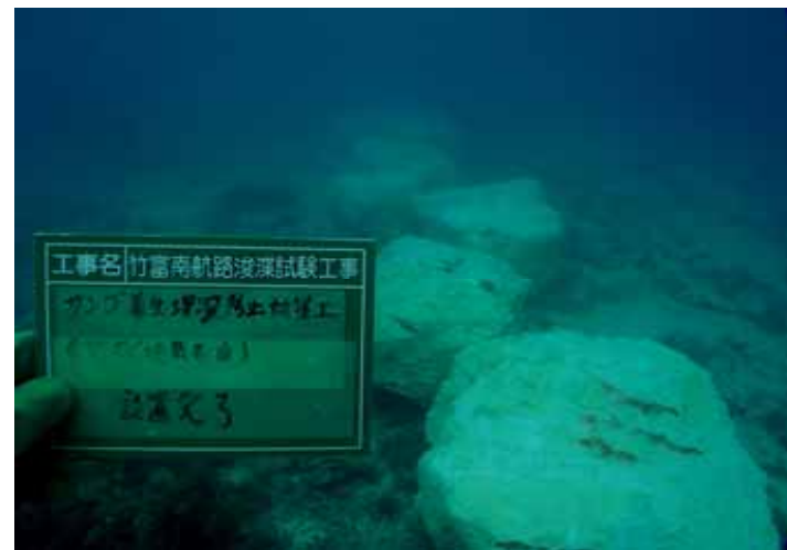
写真 2.8 設置後の自然石
