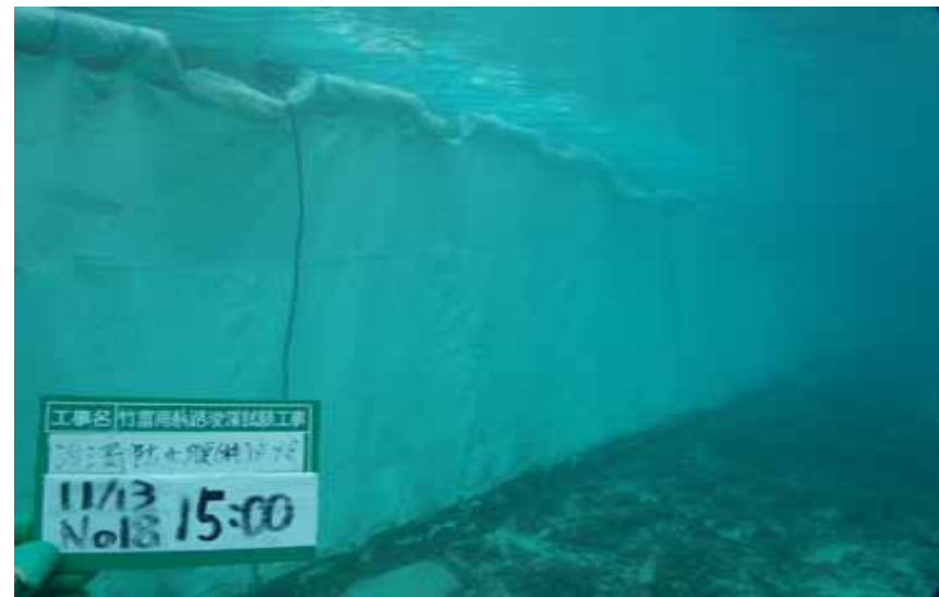
写真 2.2 汚濁防止膜の設置状況（水面下）
