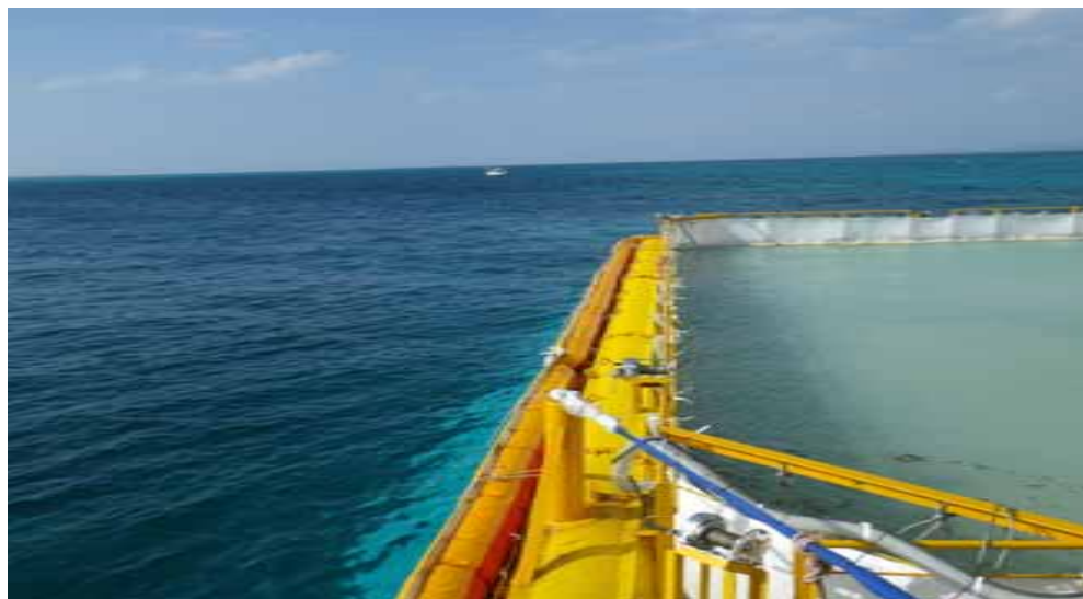
写真 2.1 汚濁防止膜（枠）の設置状況（水面上）
