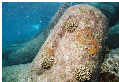
図4-14 平良港のエコブロックと着生状況
