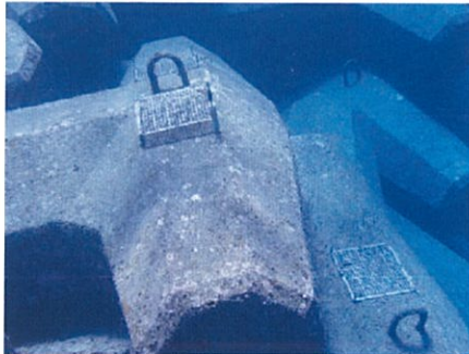
コーラルネット(耐久タイプ)の設置状況 The Durable Net Set on Wave Dissipating Block
